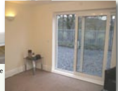
Construção nova utilizando DECO PR – rodapé e limiar do pátio
