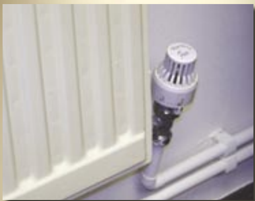
Rohy radiátorov, ventily a nechránené potrubie sú potenciálne nebezpečné
